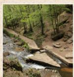
Le canal part d'un lieu reculé en amont du village où est aménagée une dérivation des eaux du Coiroux. Le canal longe le flanc de la montagne jusqu'au bourg, avec une pente de 0,5%, laissant en aval le ruisseau se transformer en
