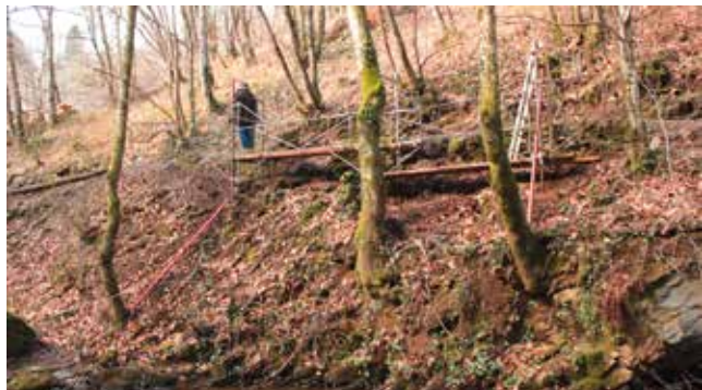
Installation du chantier
